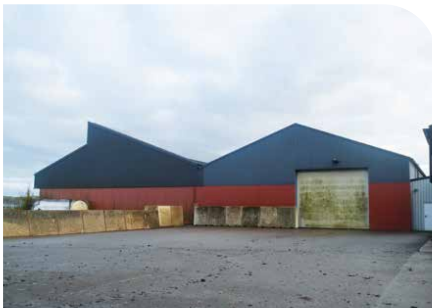
De bewaarloodsen en het erf voor de bietenopslag
